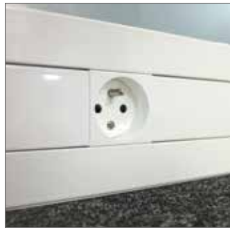
Goulotte électrique horizontale ou verticale Horizontal or vertical electrical plinth
